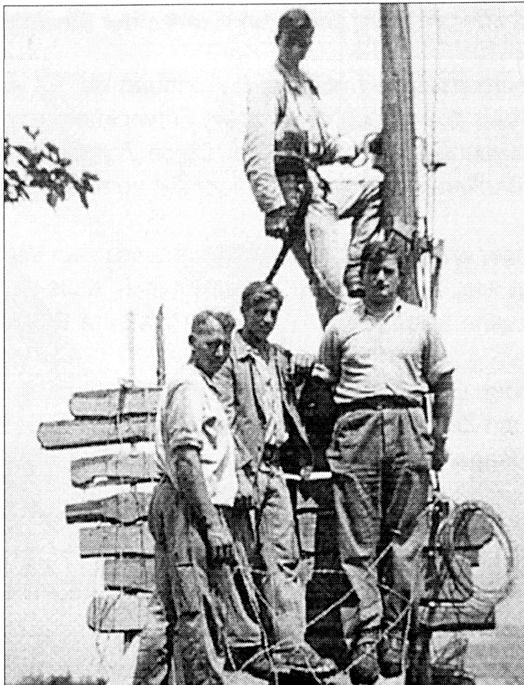
Ein Bild aus dem Jahr 1950. Um die Sägerei im Brägerhof ob Altendorf elektrisch betreiben zu können, musste beim Bergschulhaus eine provisorische Trafostation erstellt werden. Rechts im Bild: Alfons Steinegger.
